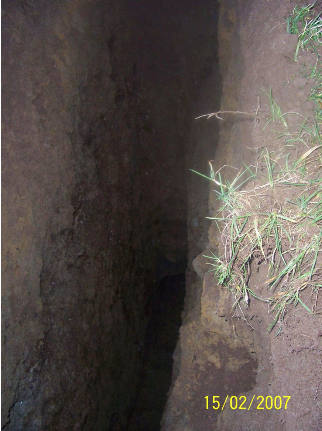
TP A1 Digging Face
