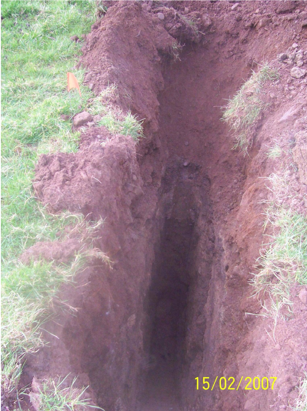
TP A2 Digging Face
