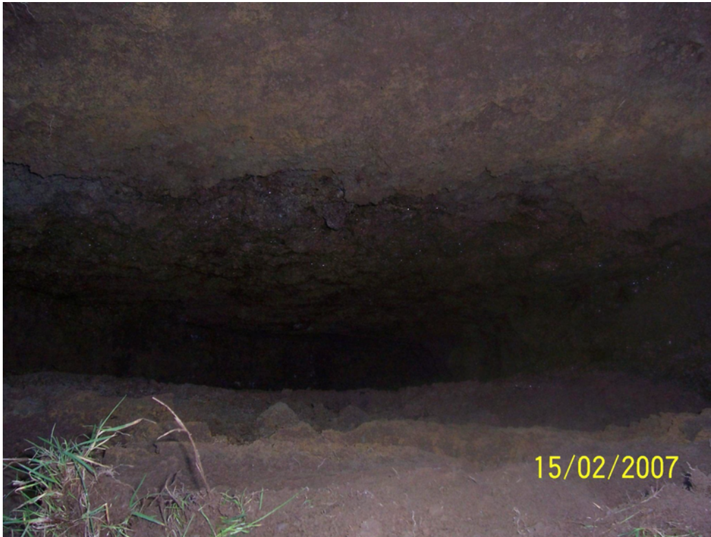
TP A1 Digging Face
