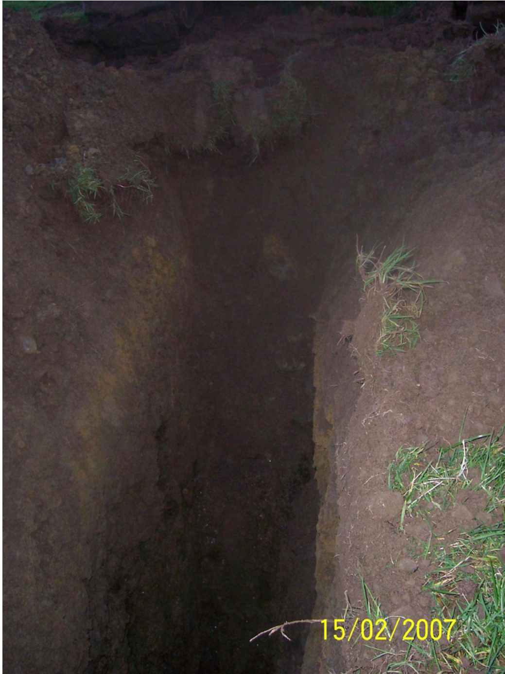
TP A1 Digging face
